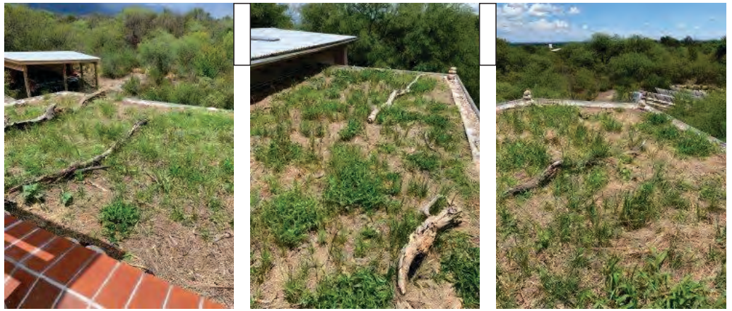
Fotos de techo vivo estudio Van Gross. Los troncos y pastos secos cubriendo el suelo, generan núcleos de humedad.
