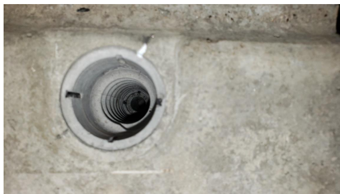
Rosca e interfaz con el hormigón
