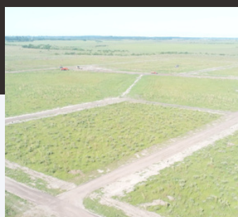
Obra Civil - Parque Fotovoltaico Bella Vista
