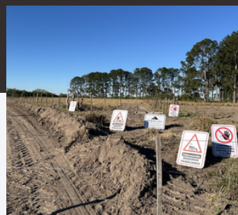
Cartelería y señalización de obra, acorde a las normativas vigentes.
