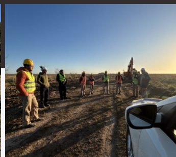
Capacitaciones en Obra
