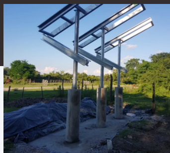
Instalación paneles solares
