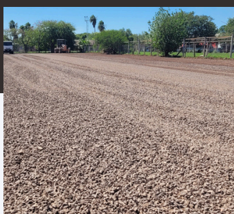
Playa de estacionamiento y maniobras
